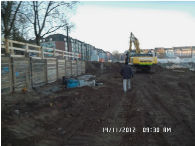
Abb. 8.12 Trägerbohlwand- verbau und Aushubarbeiten A- Straße von Osten nach Westen
