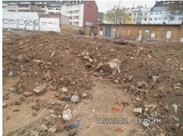
Abb. 8.28 Boden und Bauschutt durchmischt an Zwischenlagerplatz (Blick Richtung B-Straße), Foto vom 08.11.2012
