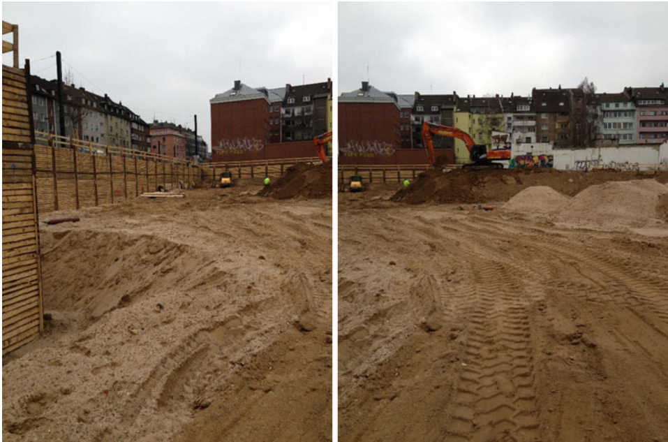
Abb. 8.22 Fotos vom 12.02.2013, Baugrubenecke A-Straße/B-Straße. Verbau B-Straße wird von Ecke Richtung Norden ausgeführt
