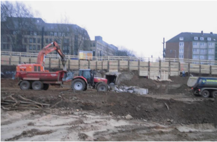
Abb. 8.17 Traktoren für Transport innerhalb des Baufeldes, Sattelzüge für Abfuhr zur Kippe, Foto vom 28.11.2012
