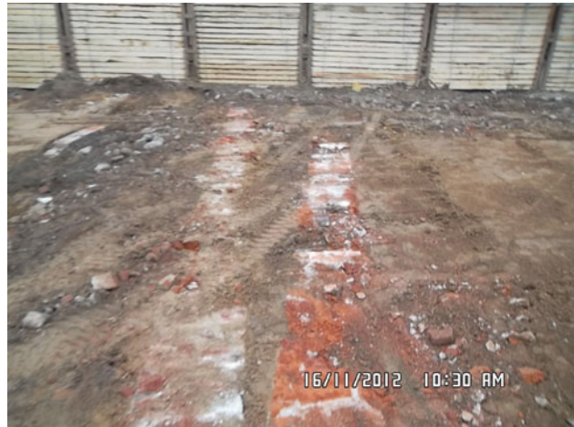
Abb. 8.24 Mit Boden verfüllte Keller vorgefunden an Verbau A-Straße, Foto vom 16.11.2012
