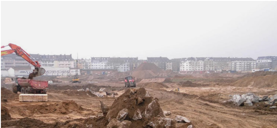
Abb. 8.16 Einsatz von Traktoren zum Zwischentransport, Foto vom 28.11.2012
