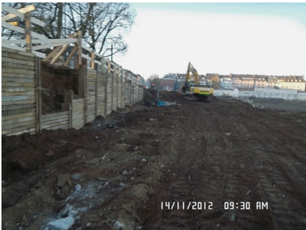
Abb. 8.13 Trägerbohlwand- verbau und Aushubarbeiten A- Straße von Osten nach Westen
