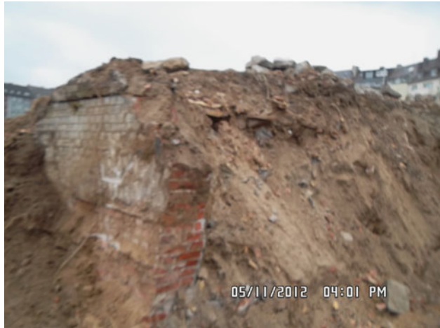
Abb. 8.23 Mauerwerkskellerwand, Foto vom 05.11.2012. Keller mit Aushub-/Abbruchmaterial verfüllt vorgefunden
