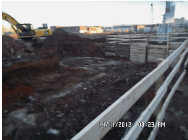
Abb. 8.26 Verbau- und Aushubarbeiten A-Straße, Sicht auf mit Aushub verfüllte Keller, Foto vom 14.11.2012
