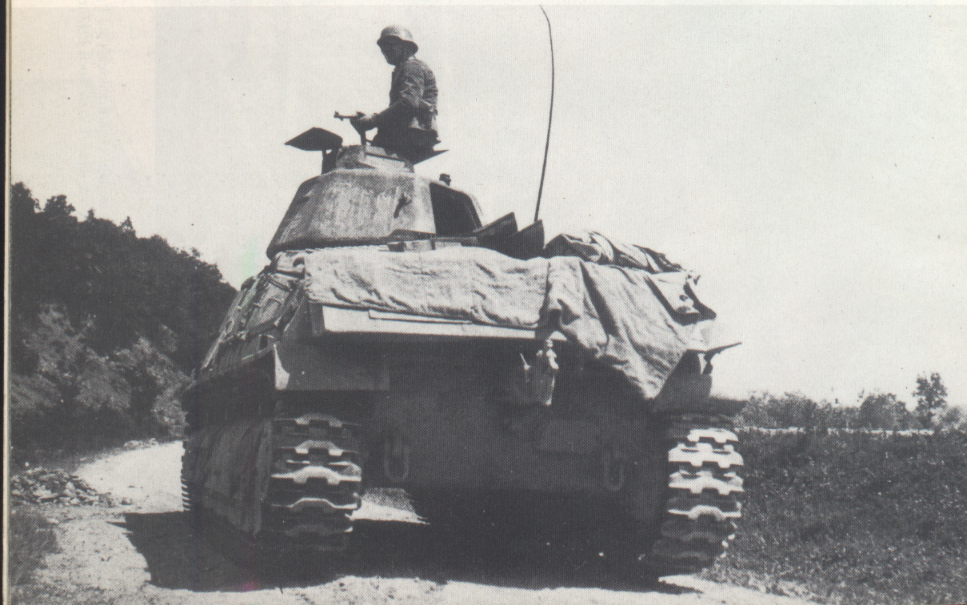
Der Befehlspanzer der I./Pz.Rgt. 202 1942 auf dem Balkan. Die S 35 hatten oft auch eine Staukiste am Heck, ähnlich denen der Hotchkiss Panzer. (FG)
