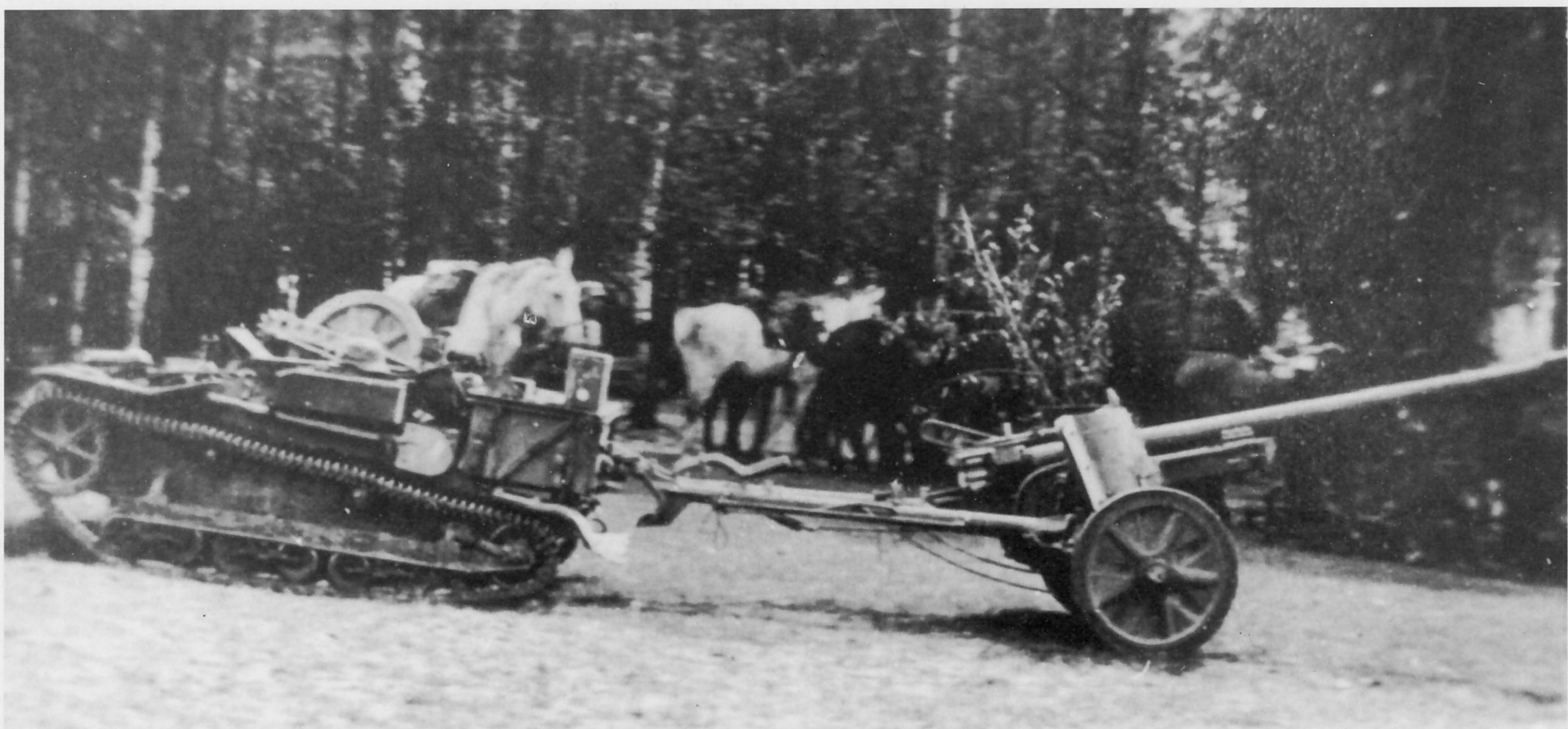
Um den Mangel an Zugmitteln in den Panzerjägerkompanien und -abteilungen auszugleichen, waren bereits vor Beginn des Krieges mit der Sowjetunion gepanzerte Munitionsschlepper UE 630 (f) an einige Divisionen des Heeres ausgegeben worden.
