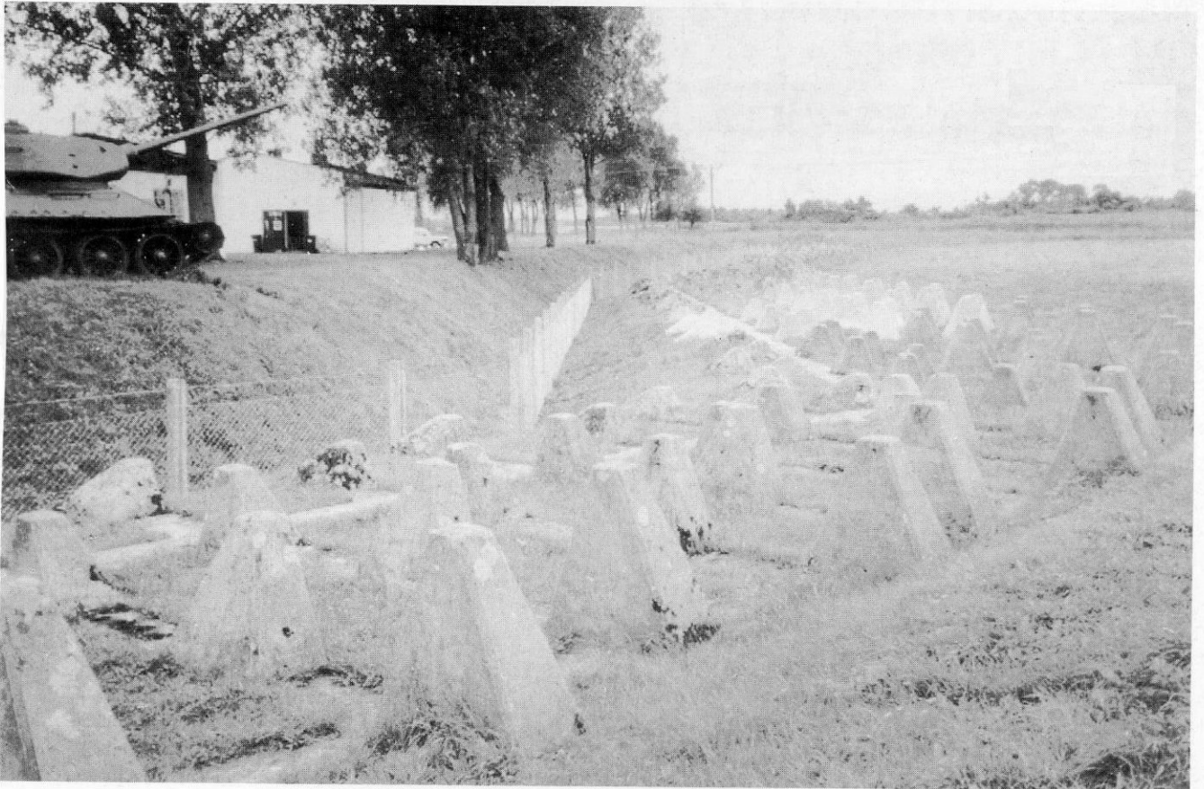
Höckerhindernisse in Stahlbeton vor dem Festungswerk 717.
