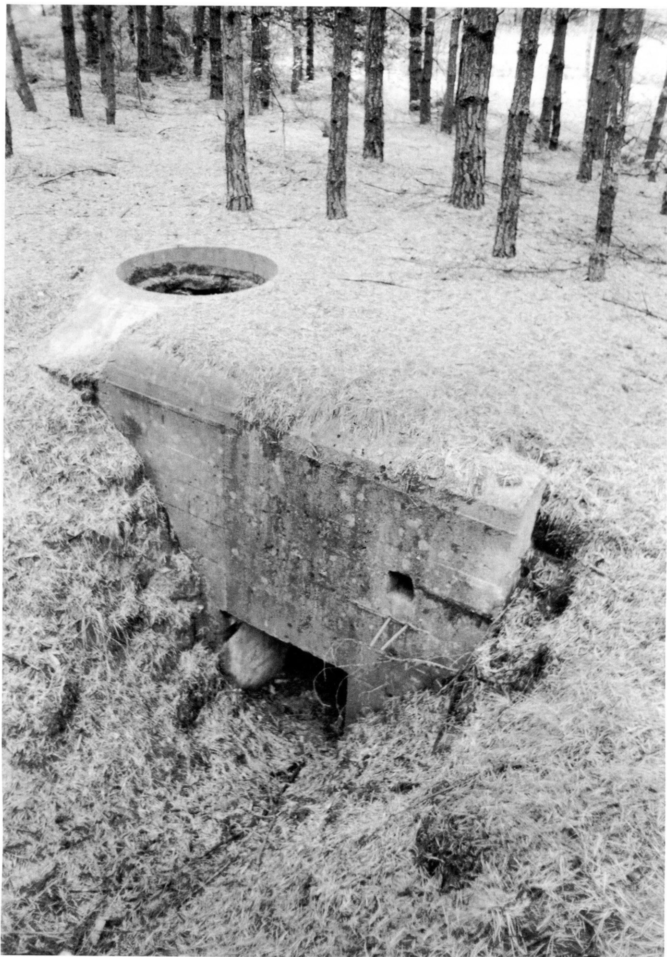
Während des Kriegsverlaufes im Osten 1944 wurden die einzelnen Bauwerke mit Ringständen Typ 58c verstärkt. Zu ihrer Bewaffnung gehörten Maschinengewehre und leichte oder schwere Waffen.
