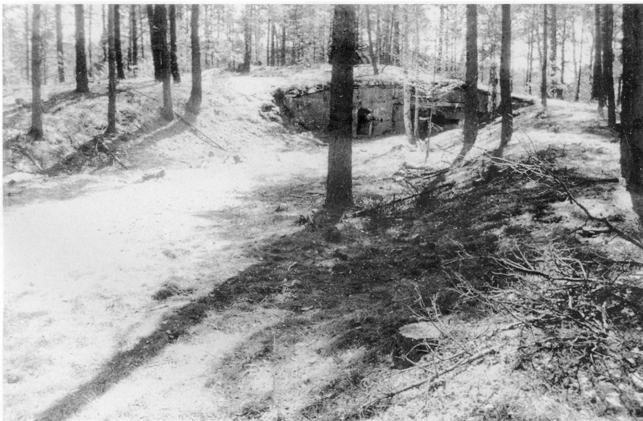
Das Bauwerk 598 im südlichen Abschnitt des Oder-Warthe-Bogens. Gut sichtbar der Dreischartenturm alter Art vom Typ 2P7, in der Panzerstärke B aus dem Jahr 1936. Die Panzerteile sind noch gut erhalten.
