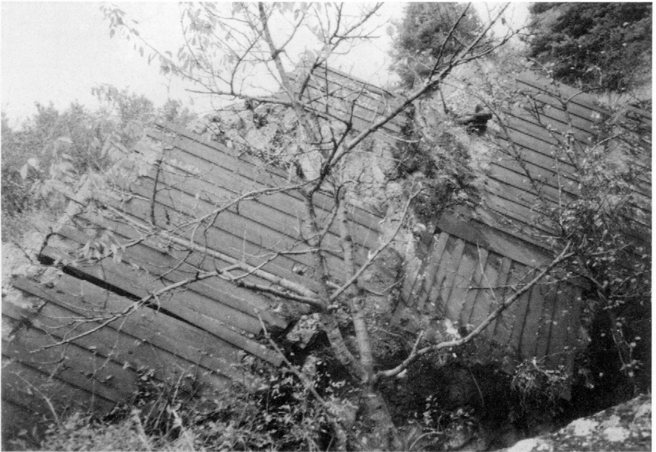
Reste des gesprengten Bauwerkes 727. Nach dem Krieg wurden Panzerteile aus der Festungsfront durch die polnische Armee zur Verschrottung aufbereitet. Dazu wurden die Bauwerke gesprengt und die Eisenteile entfernt.
