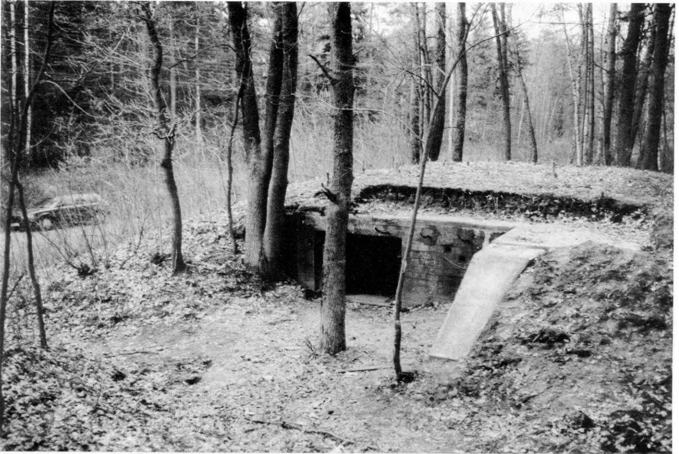
Aufgabe von Maschinengewehr-Schartenständen war es Straßen und Brücken zu verteidigen. Sie wurden als Kasematten oder Unterstände gebaut. Im Bild ein Unterstand und dahinter die zu verteidigende Straße. Aufnahme aus dem Jahr 1998.
