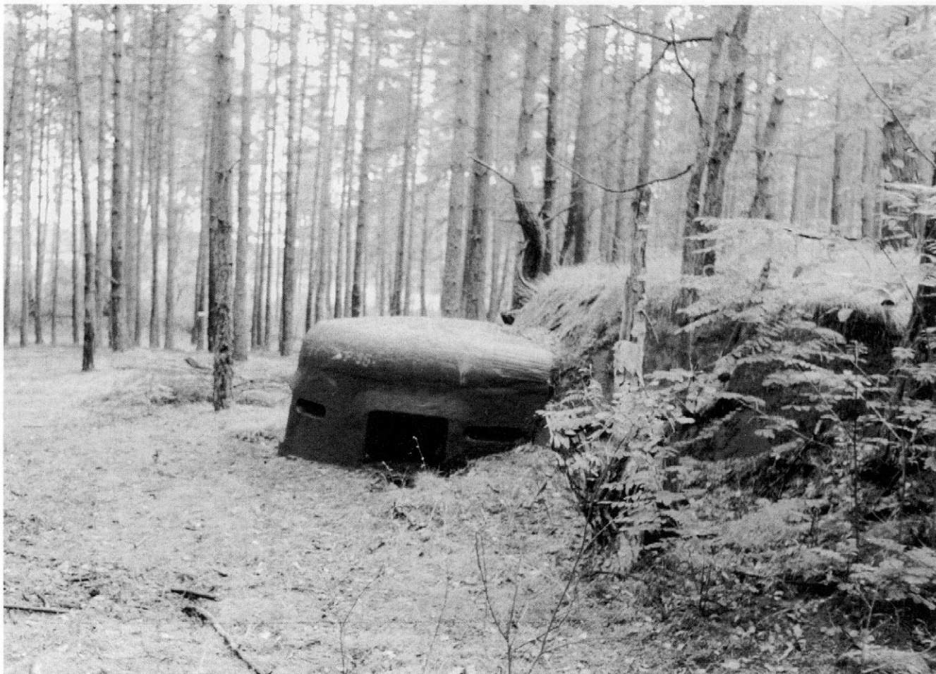
Das Bauwerk 598 im südlichen Abschnitt des Oder-Warthe-Bogens. Gut sichtbar der Dreischartenturm alter Art vom Typ 2P7, in der Panzerstärke B aus dem Jahr 1936. Die Panzerteile sind noch gut erhalten.
