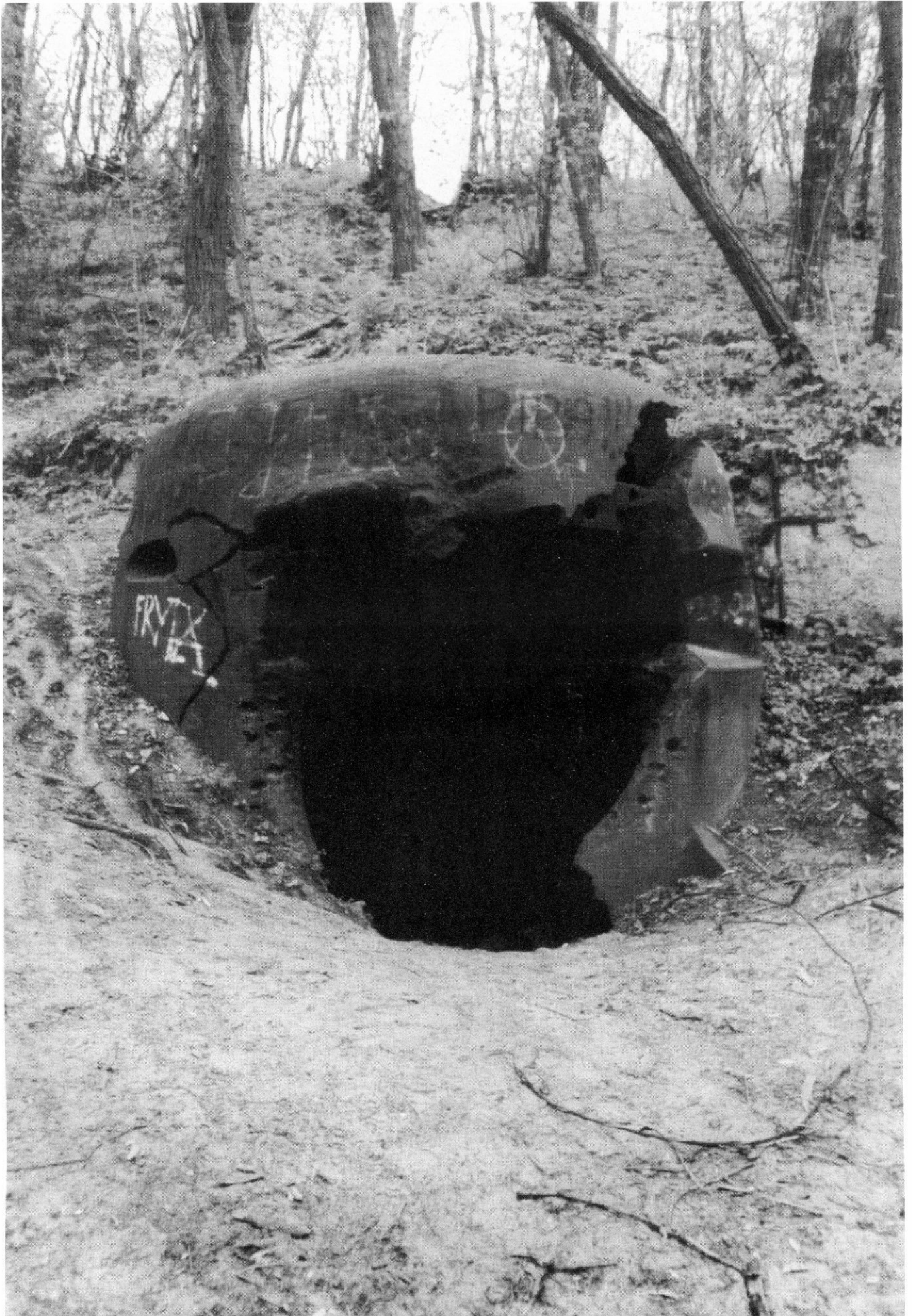
Während der Kampfhandlungen im Frühjahr 1945 gesprengter 3 Scharnturm 2 P7 des Bauwerkes 865.
