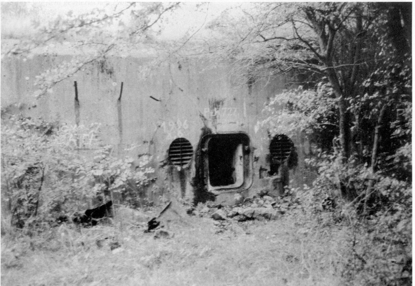
Reste des gesprengten Bauwerkes 727. Nach dem Krieg wurden Panzerteile aus der Festungsfront durch die polnische Armee zur Verschrottung aufbereitet. Dazu wurden die Bauwerke gesprengt und die Eisenteile entfernt.
