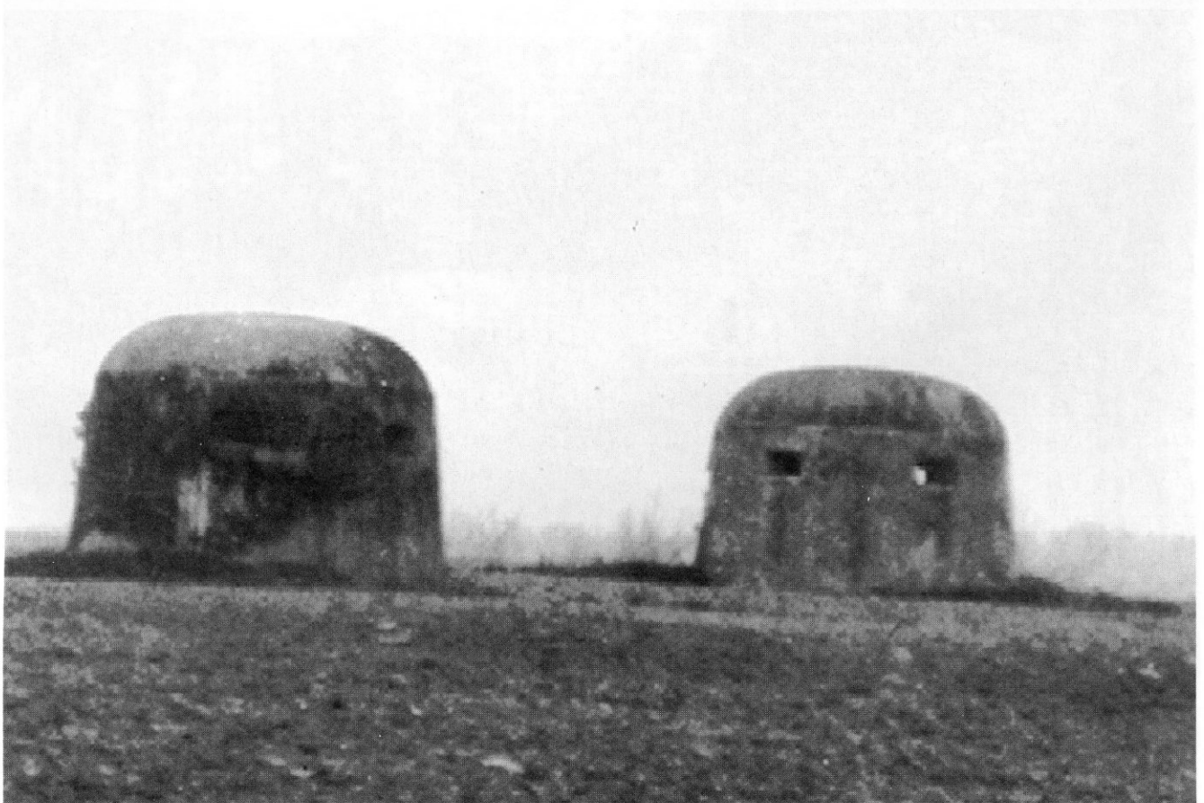
Unten: Diese aus Beton herge- stellten Schartentürme befinden sich rechts der Straße von Kalau (Kalawa) nach Hoch- walde (Wysoka). Sie dienten der Täuschung des Gegners.
