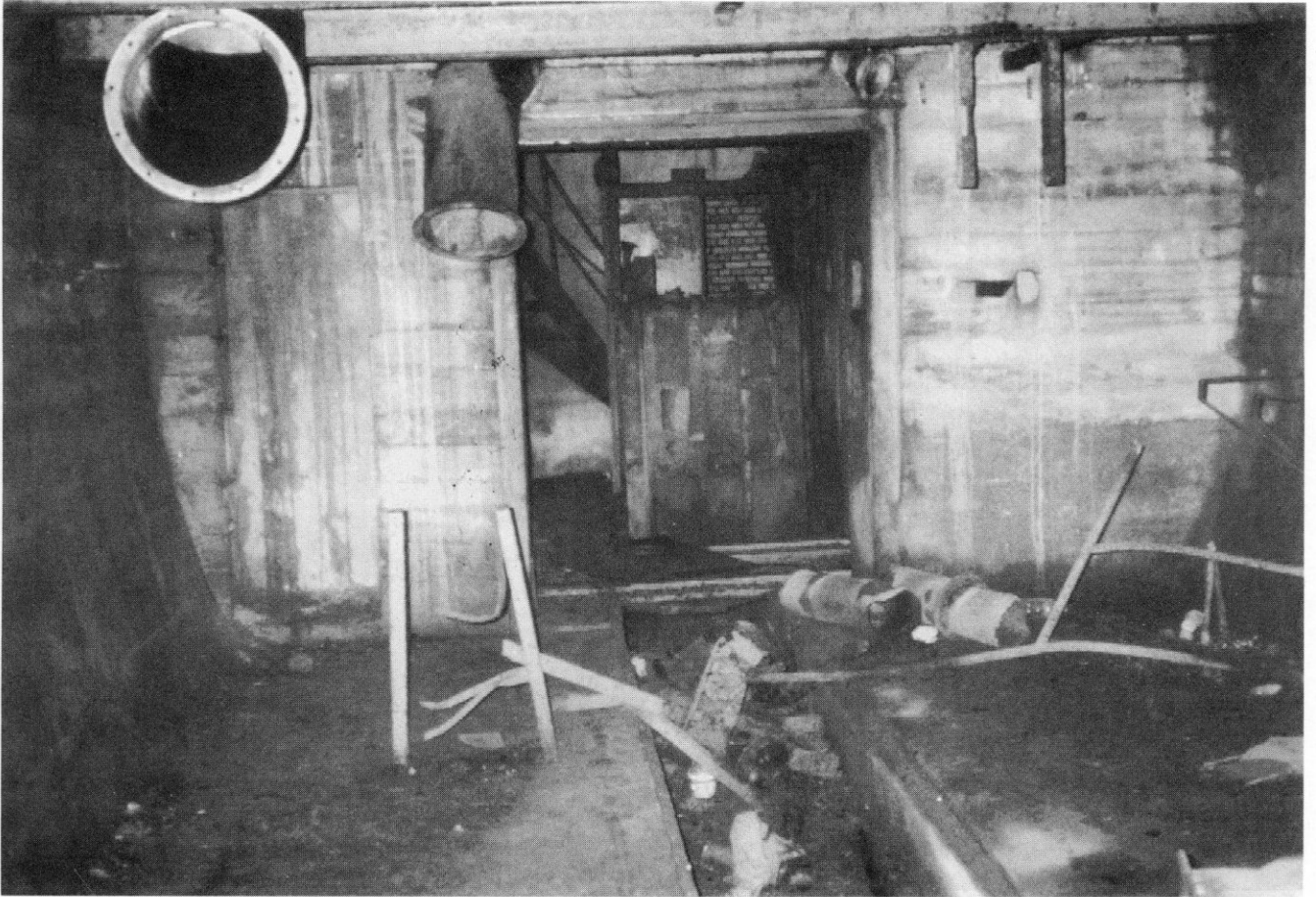
Versorgungsraum der unterirdischen Anlage. Im Inneren der Bauwerke findet man noch Reste des Filter- und Lüftungssystems. Das Bild unten zeigt einen Betonkamin zur Belüftung der unterirdischen Anlagen.
