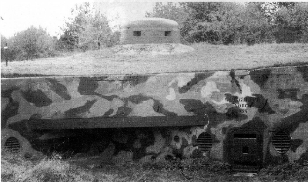
Das Panzerwerk 727 mit Eingangsverteidigung und Sechsschartenturm. Aufnahme vom Spätsommer 1998.
