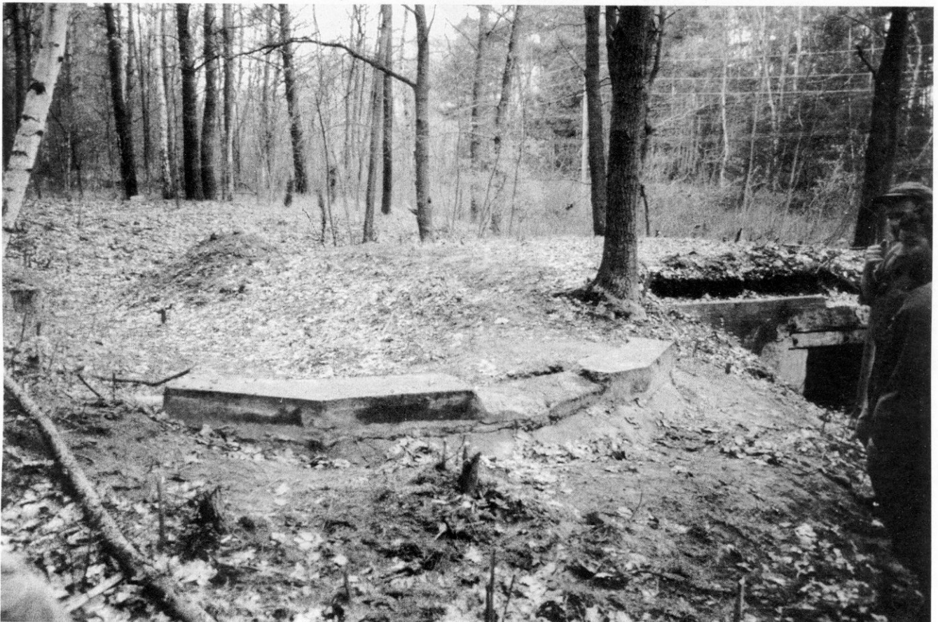
Unten: Beachte den Schutzwall aus Beton für die Panzerabwehrkanone.
