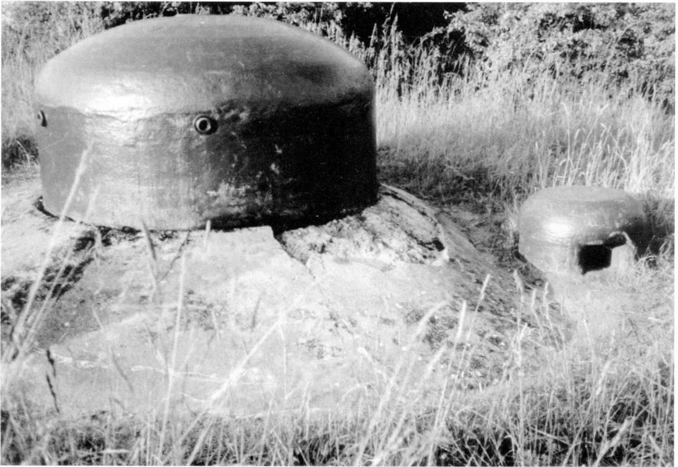
Große Bauwerke erhielten Panzertürme für Infanterie- oder Artilleriebeobachter. Die Öffnung auf der Kuppel diente der Aufnahme des Periskopes.
