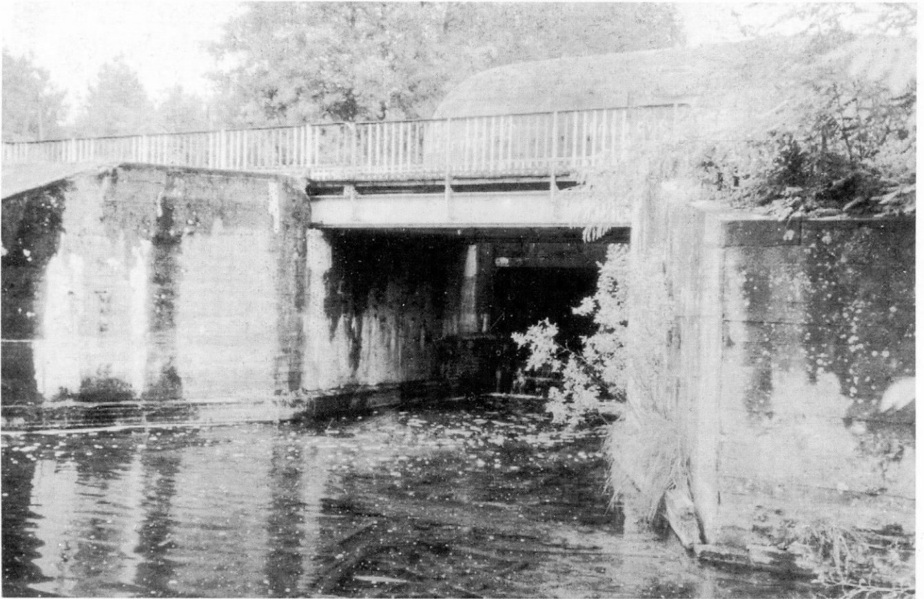
Das Bauwerk 602 (Wasserschloß) ist mit einer Kipprollbrücke versehen und war mit einer Holzverkleidung als Schuppen getarnt. Die Wasserverbindung ist der Abfluß des großen Nischlitz-Sees.
