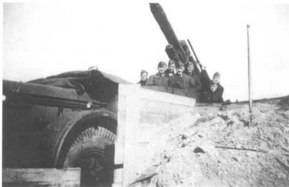
Die 8,8-cm-Flugabwehrkanone hatte eine Rohrlänge von 4930 mm = L/56.
