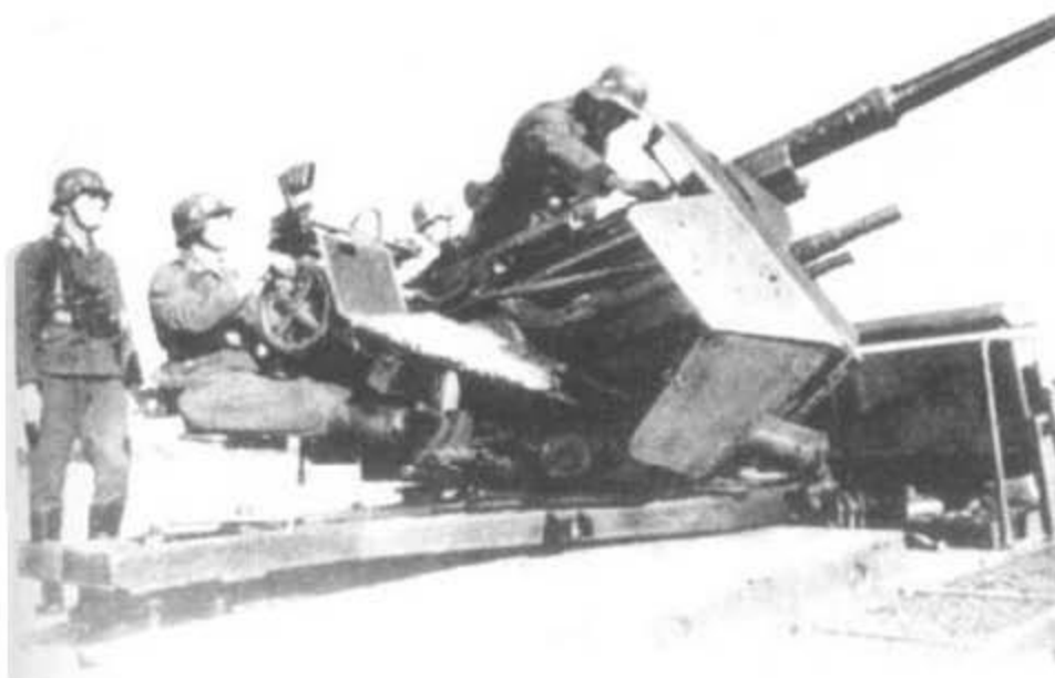
Die 3,7-cm-Flak L/60 auf dem Zugkraftwagen 8 t KMm 11 (Sd. Kfz. 7/2) wurde mit einem gepanzerten Schutzschild versehen.
