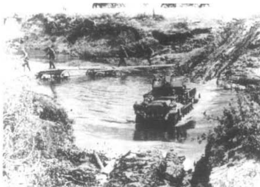
Die Selbstfahrlafette auf dem Fahrgestell des Zugkraftwagen 1 t Demag D 7 war wadfähig bis 700 mm.
