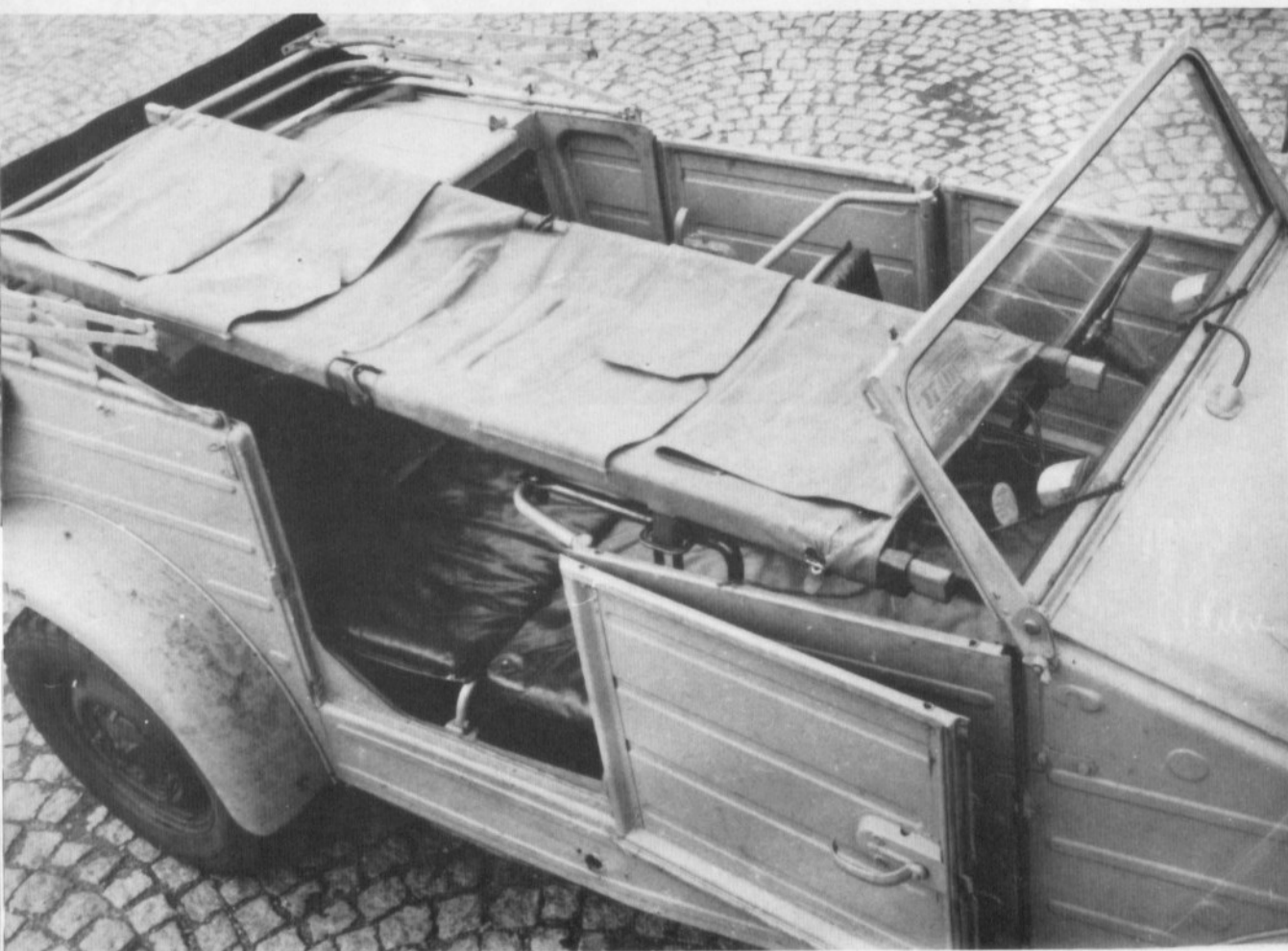
Verwundetentransportwagen. Das Foto zeigt die erste Ausführung zum Transport von zwei Verwundeten.
