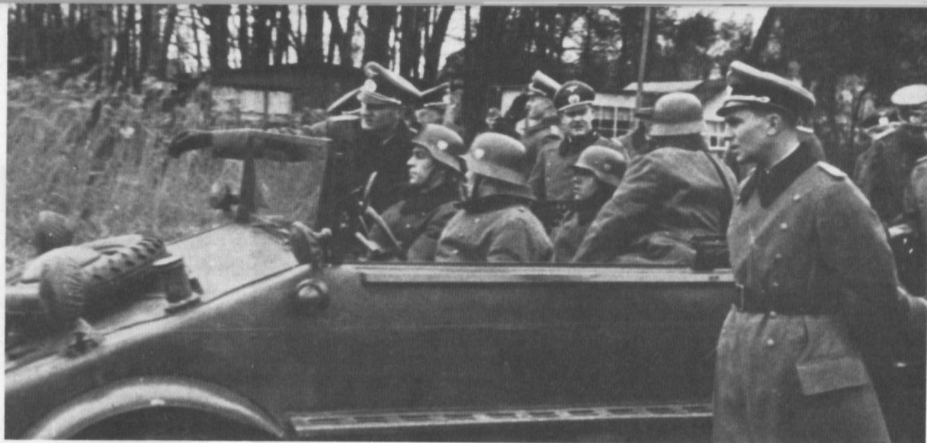
Schwimmwagen Typ 128 bei der Erprobung H.V.A. Versuchsabteilung Wünsdorf. Das Foto zeigt den 1. Prototyp noch mit der kübelwagenähnlichen Karosserie.
