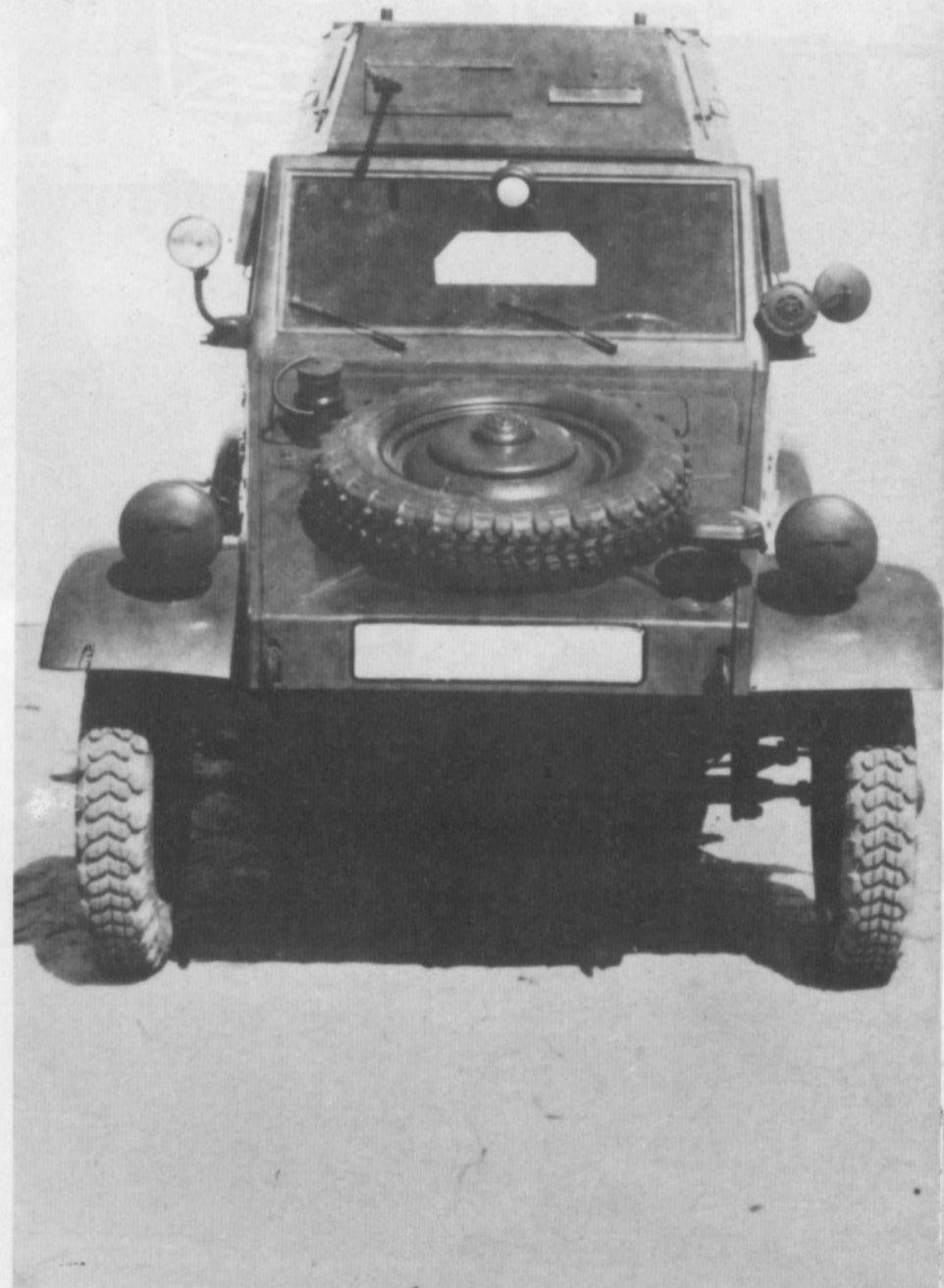
Rechts: Typ 823 Panzerkampfwagen-Attrappe mit Turmauf- bau für MG, ohne Laufradverkleidung. Aufnahme 17. Mai 1941. Weitere Aufnahmen sind im ersten VW-Band (Nr. 58) dieser Reihe zu finden.
