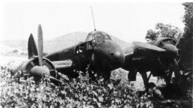
Bruchgelandeter Ju 88 C-Nachtjäger, dessen Besatzung zur Sicherheit die hintere Kabinenverkleidung abgeworfen hatte.
