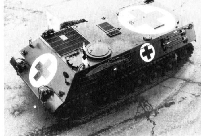
Prototyp 2 HK 2/2, SPz Krankenkraftwagen der Fa. Henschel (1960 – 1963). Die Entwicklung dieses Fahrzeugs wurde nicht weiterverfolgt, da auch für diese Zwecke der MTW M 113 eingesetzt werden konnte.
