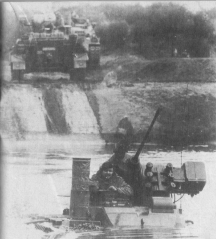
SPz Marder A1+ beim Tiefwaten; im Hintergrund: Bergepanzer und Bergehilfspanzer.
