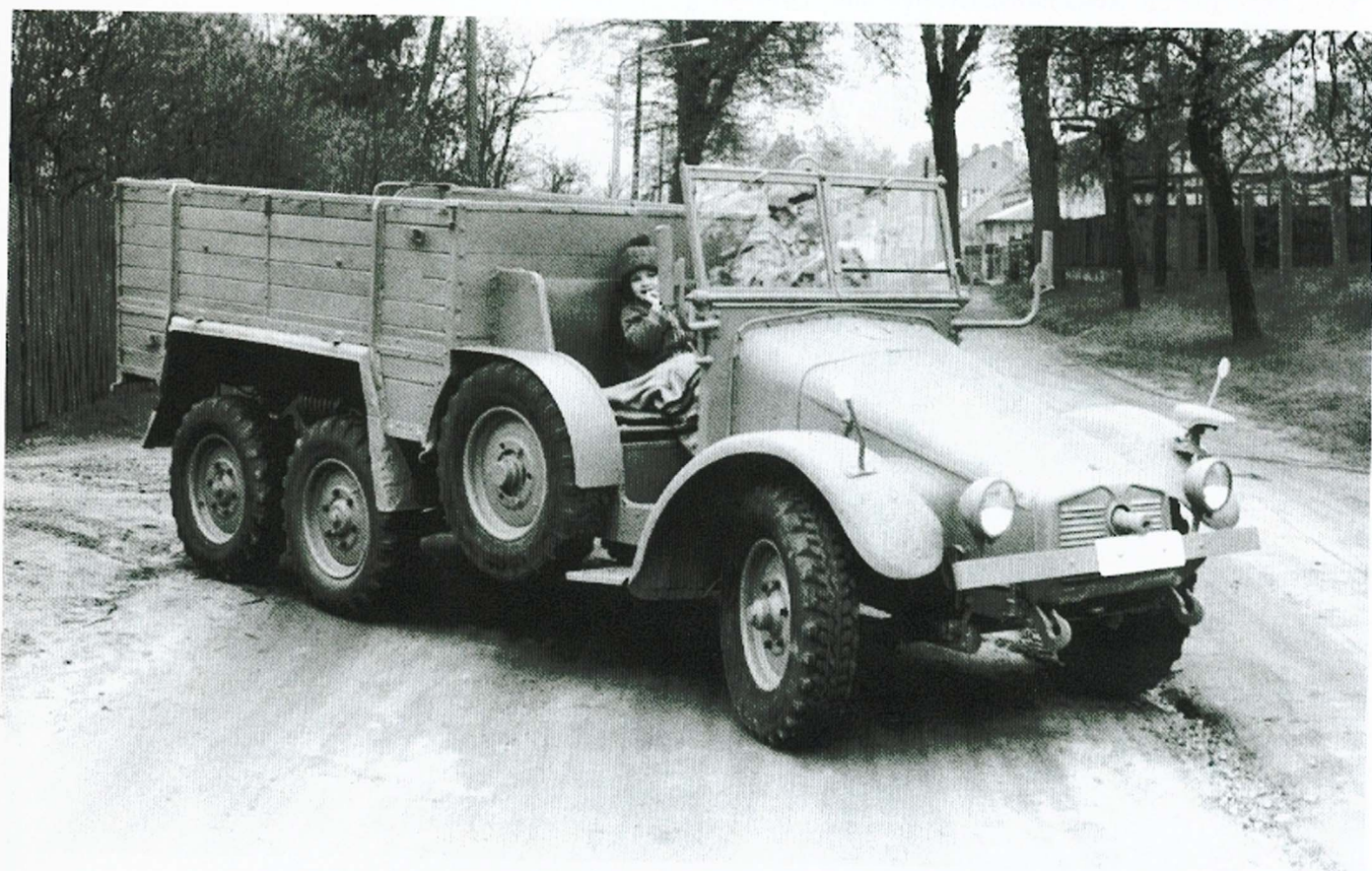
Für den leichten geländegängigen Lastkraftwagen 1,5 t L2H143 mit Vorderradlenkung ergab sich ein Wendekreis von 16 m. Der Kraftstoffverbrauch ist bei Straßenfahrt mit 30 l, bei Fahren im mittleren Gelände mit 50 l pro 100 km angegeben.
