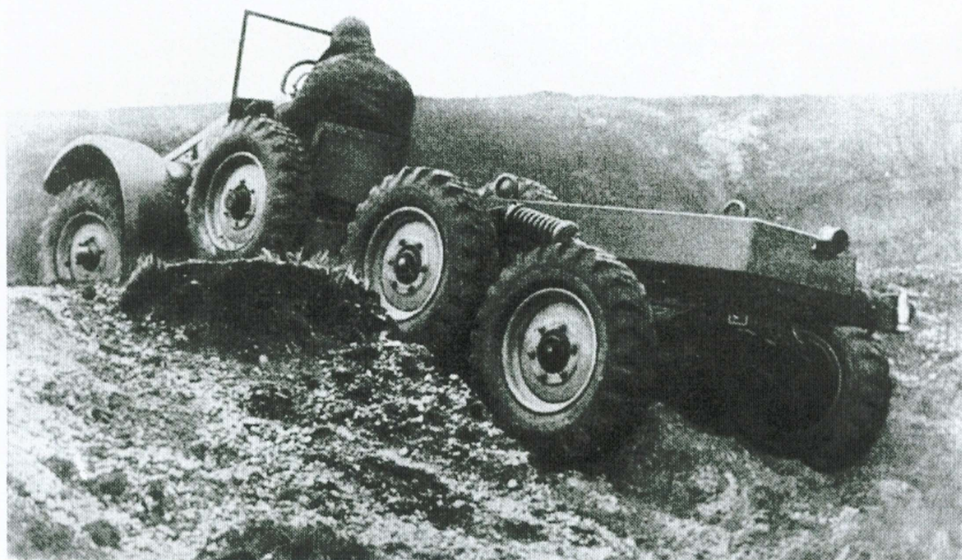
Erprobung des Fahrgestells eines leichten geländegängigen Lastkraftwagen 1,5 t L2H143 auf dem Erprobungsgelände des Heereswaffenamtes Bad Berka (Thüringen).
