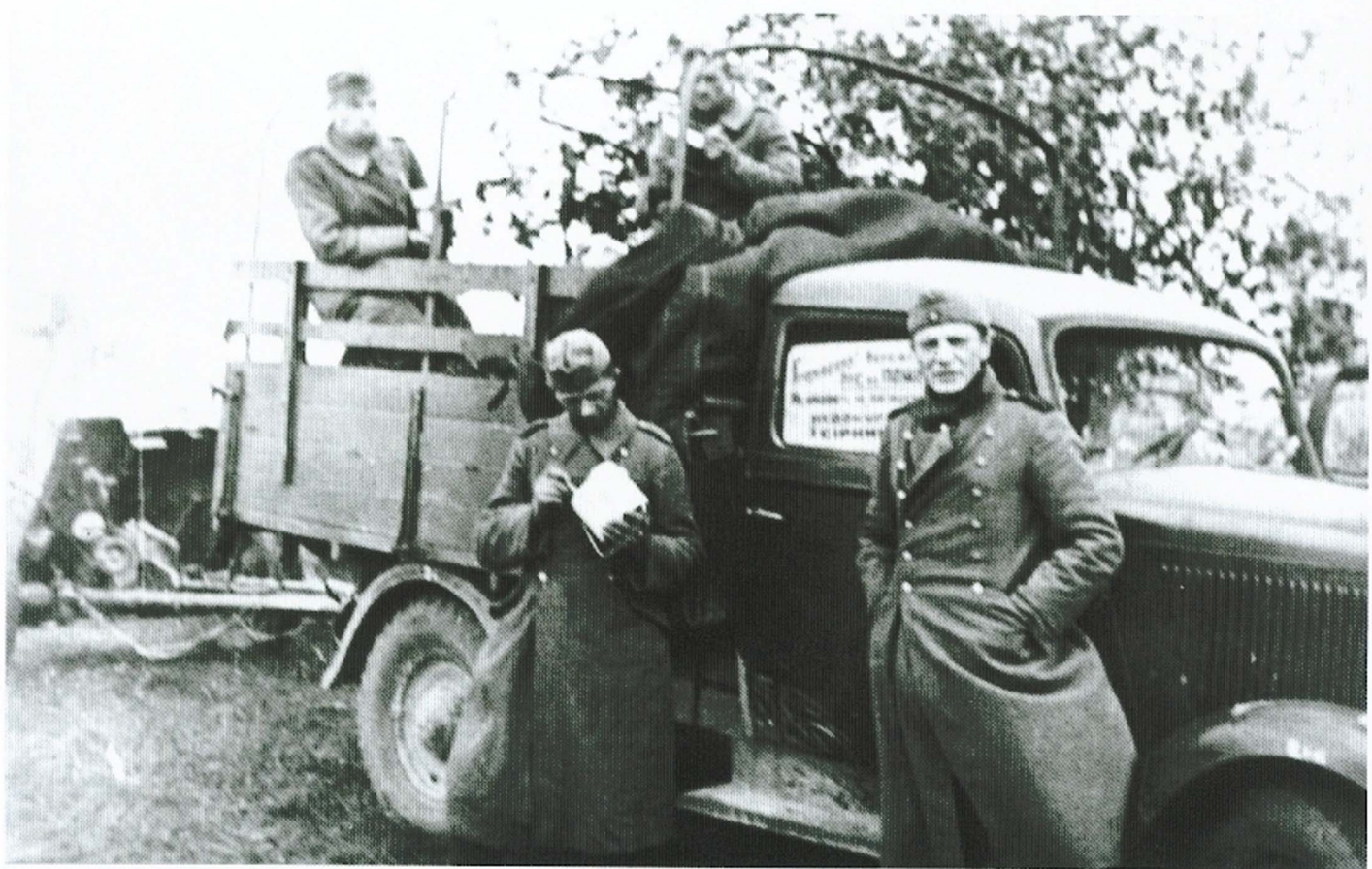
Als Ersatz für Protzkraftwagen (Kfz. 69) erhielten die Panzerabwehrabteilungen und Divisionen, die zum Sommer 1939 aufgestellt worden sind, zivile Lastkraftwagen als Zugmittel. Hier im Bild ein leichter Lastkraftwagen 1,5 t Opel-Blitz mit angehängter 3,7-cm-Panzerabwehrkanone L/45. Die Fahrzeuge genügten in keiner Weise den Anforderungen der Truppe.
