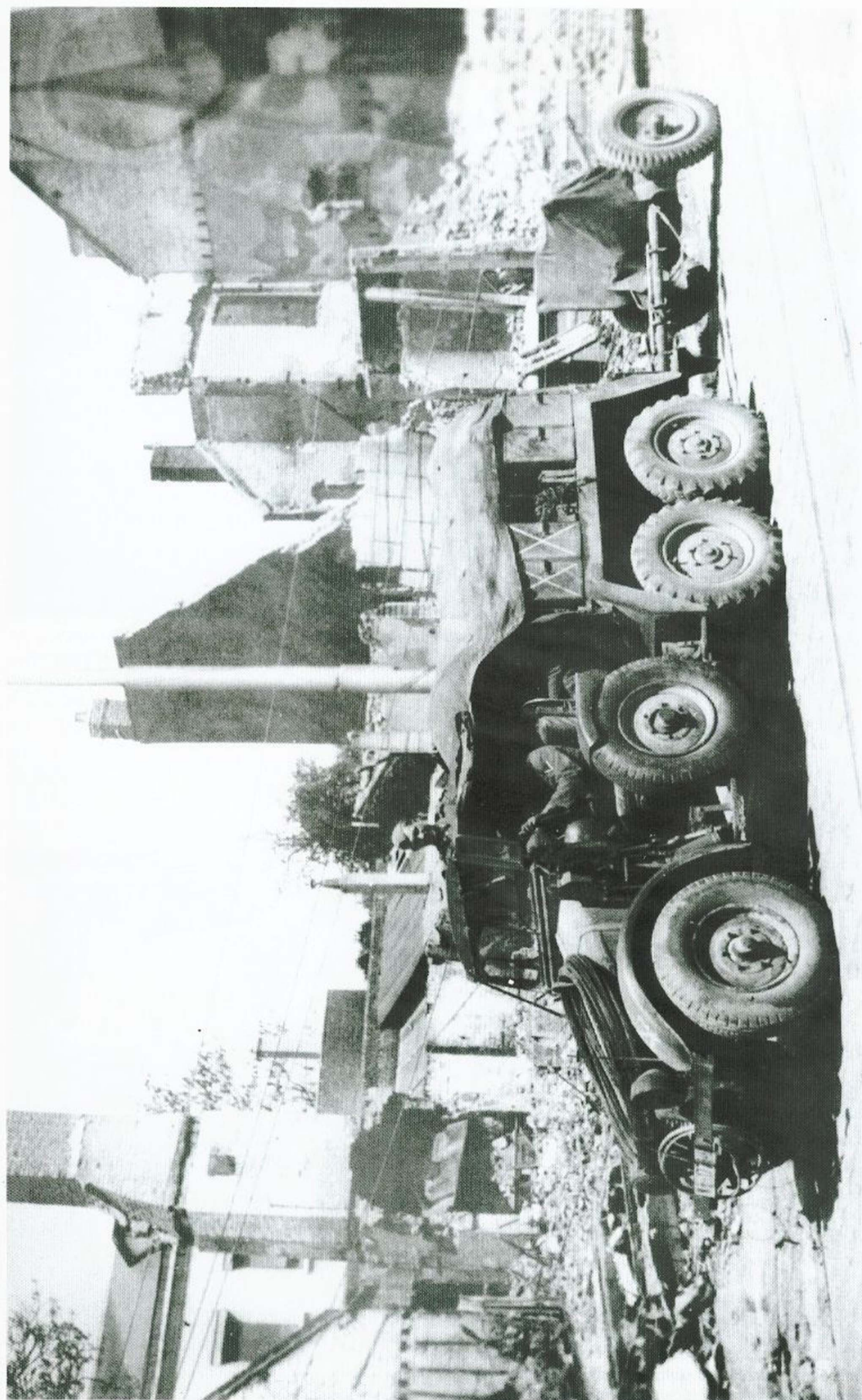
Diese Aufnahme eines Protzkraftwagens (Kfz. 69) mit angehängter 3,7-cm-Panzerjägerkanone ist während des Frankreich-Feldzuges 1940 entstanden. Fahrzeug und Geschütz gehörten zur 1. Kompanie der Panzerjägerabteilung einer Panzerdivision. Gut zu erkennen sind die typischen Merkmale des Protzkraftwagens, wozu die über den beiden Hinterachsen angeordneten Munitions- und Zubehörkästen für das Geschütz gehören.
