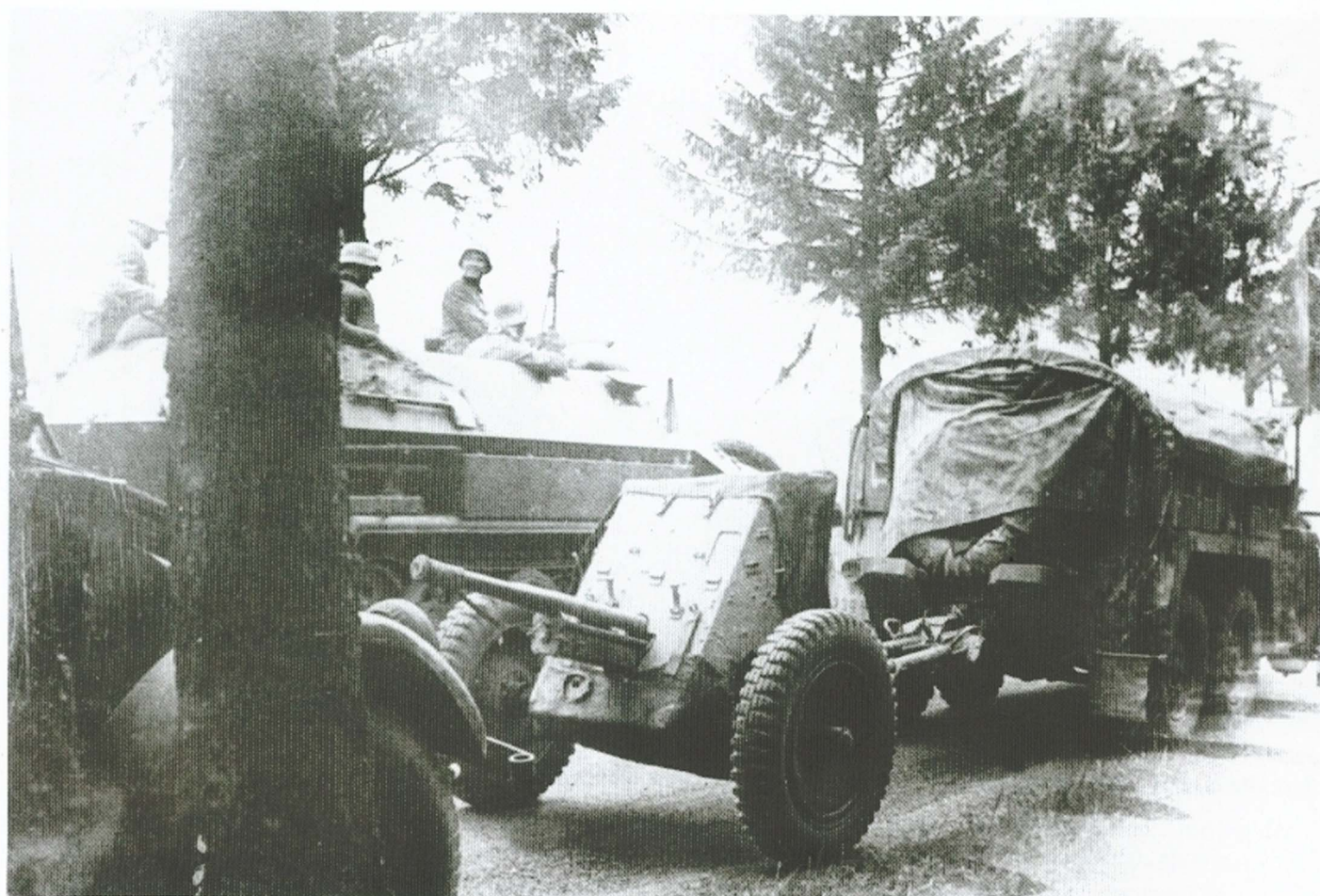
Ein Protzkraftwagen (Kfz. 69) mit angehängter 3,7-cm-Panzerabwehrkanone L/45 während des Polenfeldzuges. Links im Bild einer der im September 1939 noch seltenen gepanzerten Mannschaftstransportwagen HfKfz.251).
