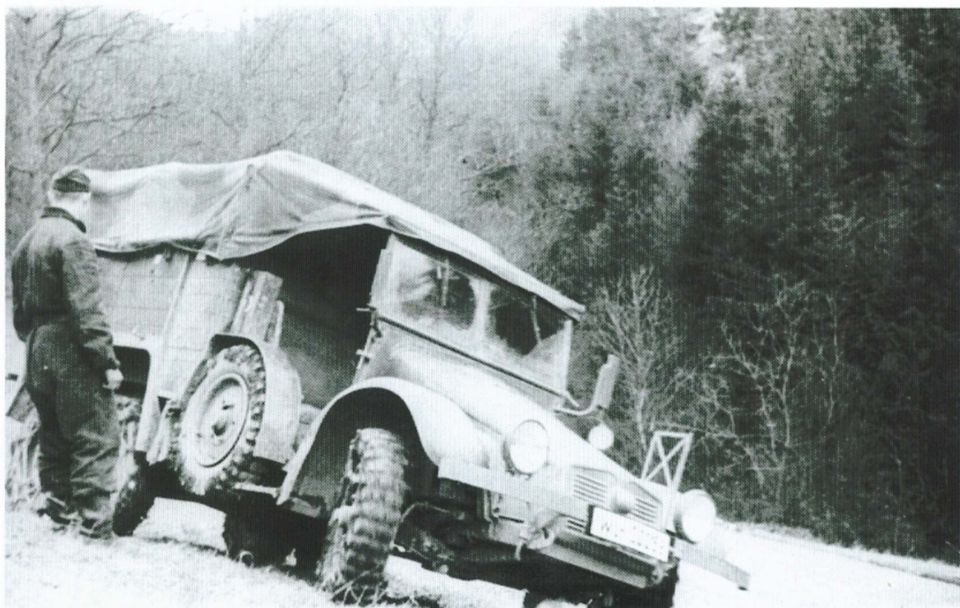
Ein leichter Flakkraftwagen (Kfz. 81) mit aufgezogener Gleitschutzkette auf den beiden Hinterachsen. In schwerem Gelände genügte es, die Antriebsachsen mit dem Gleitschutz zu belegen.
