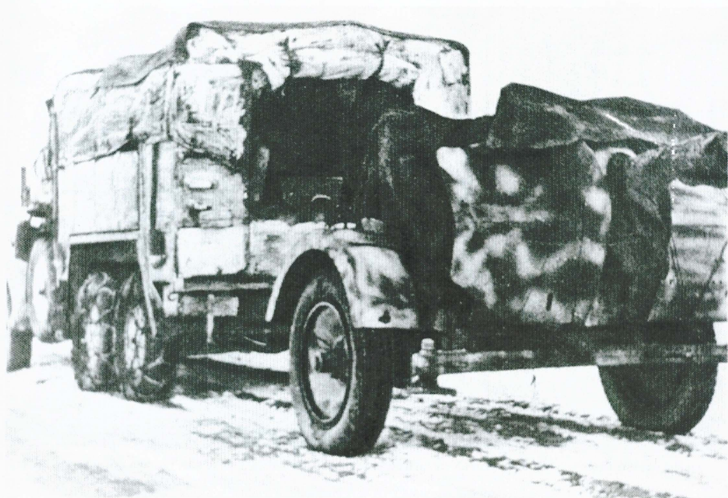
Leichter Flakkraftwagen (Kfz. 81) mit angehängter 2-cm-Flak 38 im Winter 1943/44 an der Ostfront. Beachte den Tarnanstrich des Zugmittels und des Geschützes.
