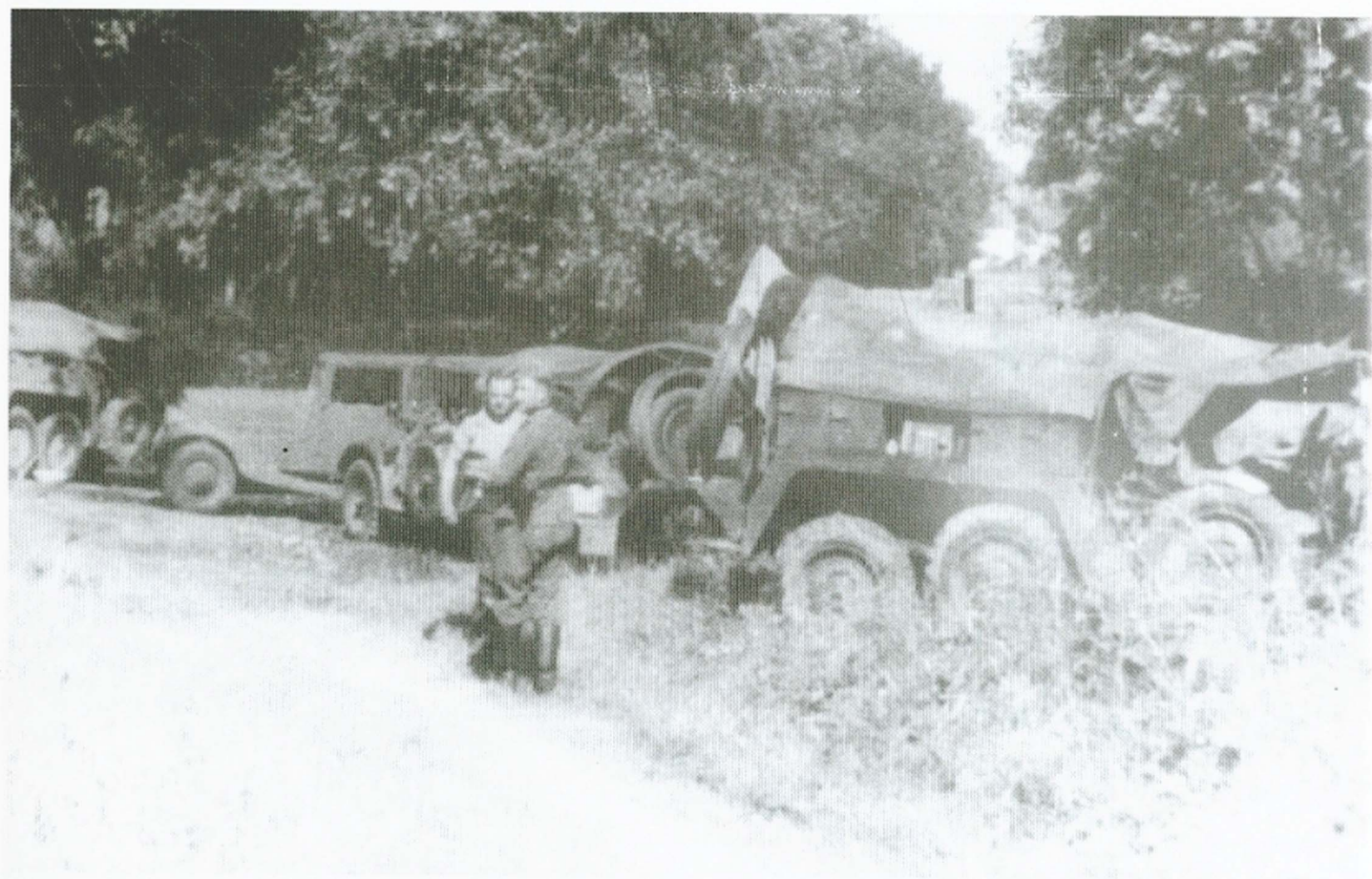
In der Protzenstellung einer Panzerabwehrkompanie. Panzerabwehrkompanien der Panzerjägerabteilung von Divisionen waren mit Protzkraftwagen (Kfz. 69) ausgestattet. Infanteriepanzerabwehrkompanien in den Infanterieregimentern erhielten als Zugfahrzeuge Kübelwagen (Kfz. 11).
