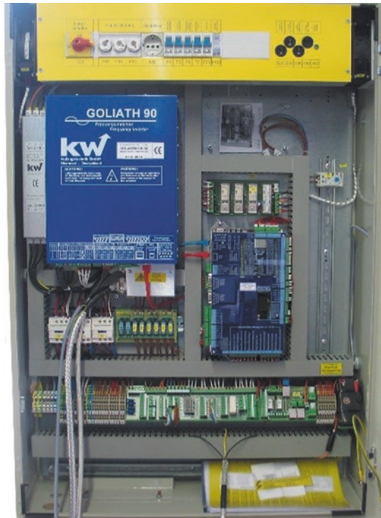
Abb. 4.55 Steuerung für eine Aufzugsanlage mit Maschinenraum (Quelle: KW Aufzugstechnik GmbH, Oberursel)
