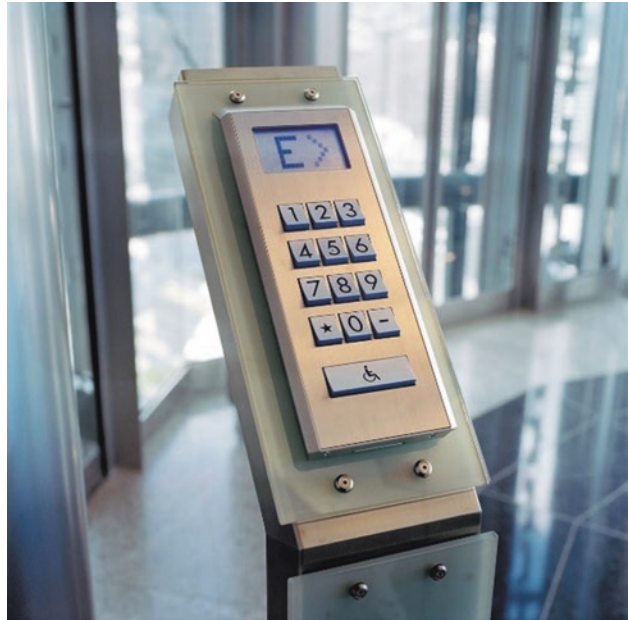
Abb. 4.63 Zehnertableau (Quelle: Schindler Aufzüge und Fahrtreppen GmbH, Berlin)
