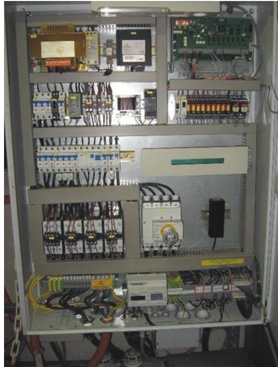
Abb. 19.29 Steuerschrank einer Fahrtreppe, aufgestellt im Maschinenraum (Quelle: Autor)
