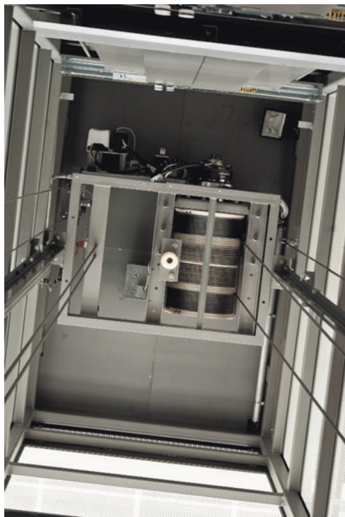
Abb. 5.20 Trommelantrieb im Schachtkopf (Quelle: SLC Sautter Lift Components, Stuttgart)
