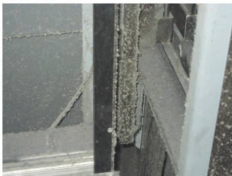
Abb. 9.2 Flusenbildung im Schacht (Quelle: Autor)
