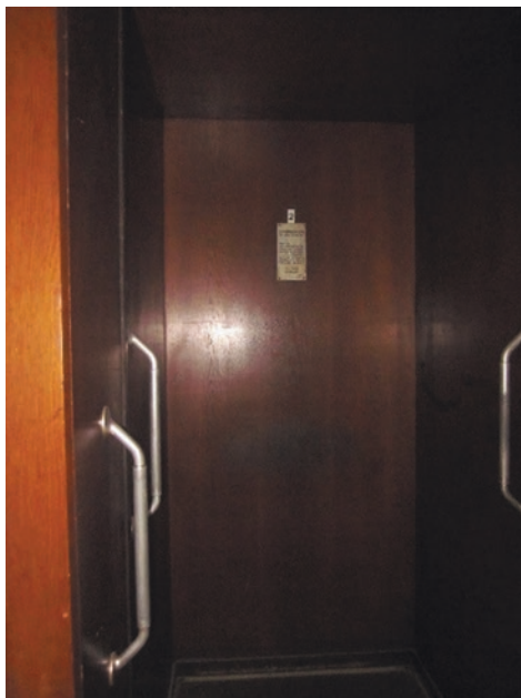
Abb. 5.9 Fahrkorb eines Paternosters (Quelle: TECHNOSEUM (Landesmuseum für Technik und Arbeit), Mannheim)
