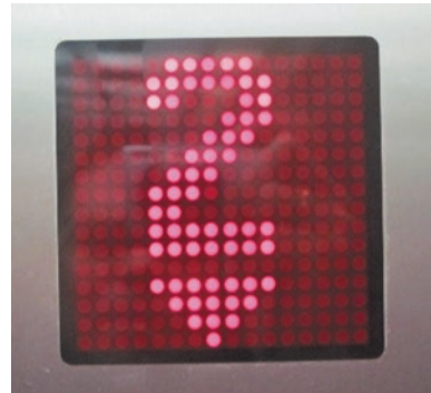
Abb. 4.74 Anzeigeeinheit im Fahrkorbletisch (Quelle: Autor)
