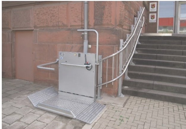
Abb. 5.24 Rollstuhl-Schrägaufzug im Außenbereich. (Quelle: HIRO Lift ©, Bielefeld)
