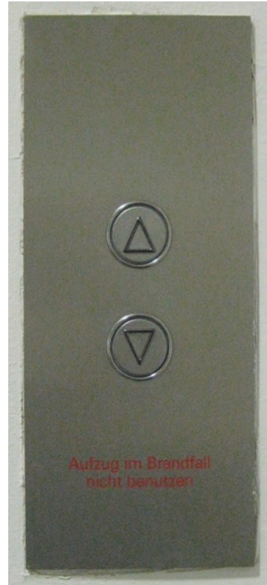
Abb. 4.60 Außenruftableau Zwei-Knopf-Steuerung der Zwischenhaltestellen (Quelle: Autor)
