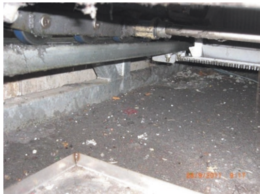
Abb. 22.1 Flusenbildung im Stufenbandsystem (Quelle: Autor)
