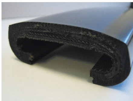
Abb. 19.13 Flachhandlauf (Quelle: Boettcher Systems, Gelsdorf)
