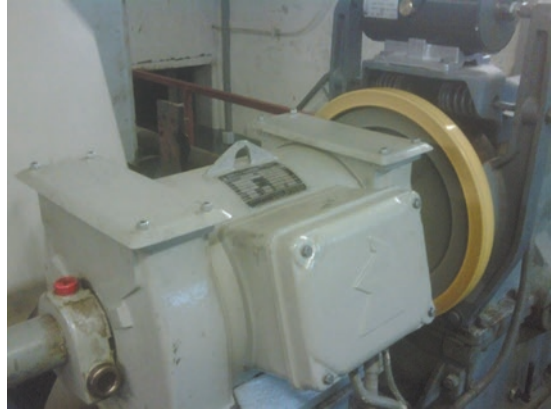
Abb. 5.13 Antriebseinheit im Maschinenraum (Quelle: Autor)
