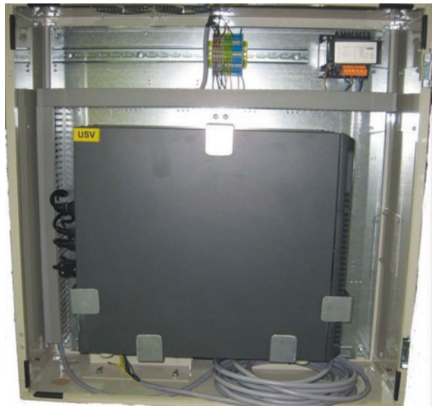
Abb. 4.64 Akkueinheit für die Evakuierung bis zur Haupthaltestelle (Quelle: KW Aufzugstechnik GmbH, Oberursel)
