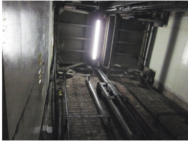
Abb. 4.50 Stützkette mit den Gegengewichten (Quelle: Autor)
