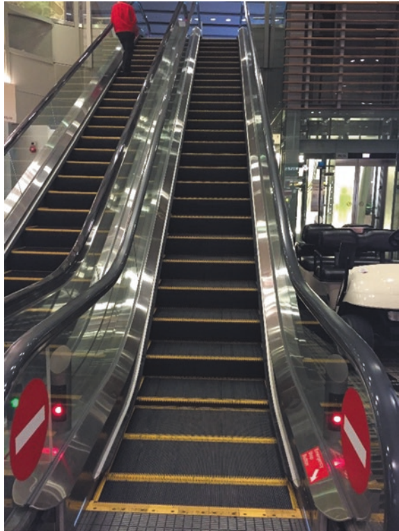
Abb. 19.7 Stufen mit Markierung (Quelle: Autor)
