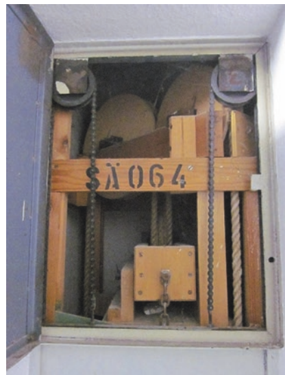
Abb. 5.6 Seilrollen im Schachtkopf (Quelle: Autor)
