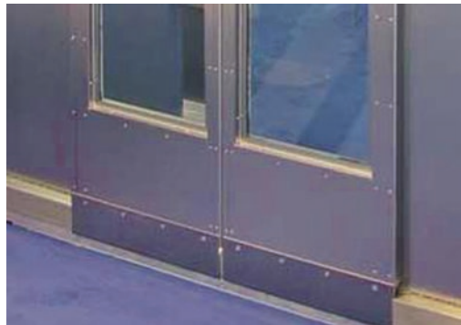
Abb. 4.93 Schwelle mit verdeckter unterer Führung (Quelle: Meiller Aufzugstüren, München)
