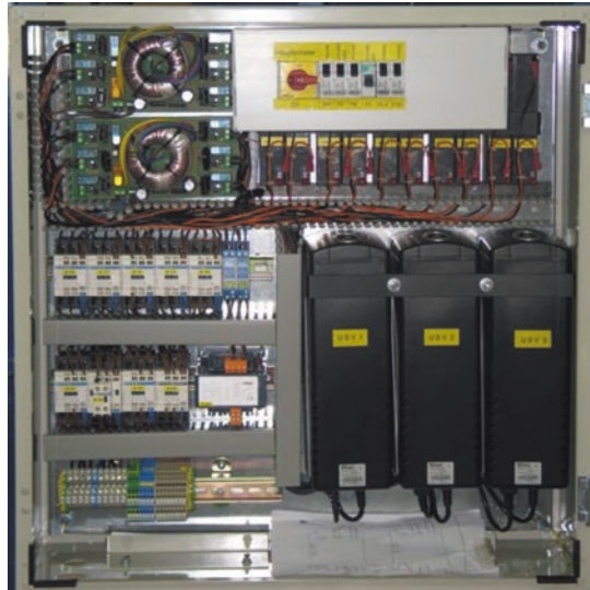
Abb. 4.65 Akkueinheit für eine Fahrt zur nächsten Haltestelle (Quelle: KW Aufzugstechnik GmbH, Oberursel)
