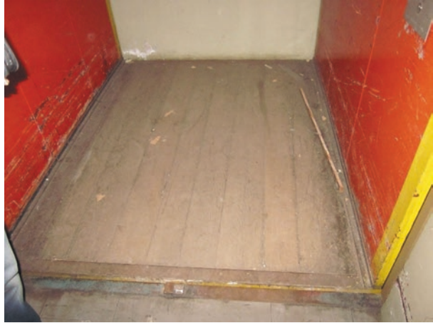
Abb. 4.90 Älterer Fahrkorb ohne Fahrkorbabschlusstür und Holzfussboden (Quelle: Autor)
