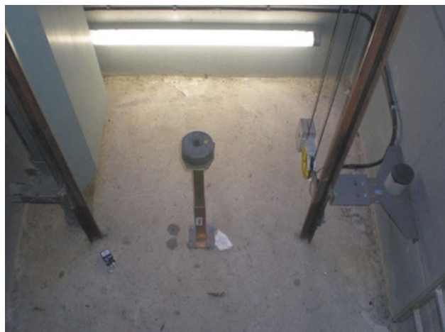
Abb. 4.4 Energiespeichernder Puffer mit Pufferstütze (Quelle: Autor)
