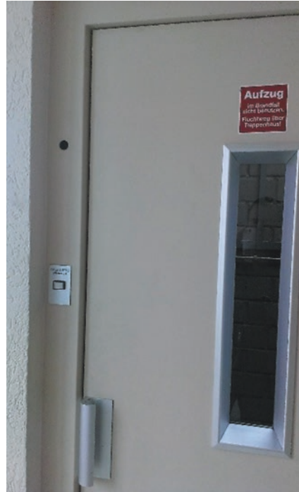
Abb 4.89 Notentriegelung im Türrahmen (Quelle: Autor)
