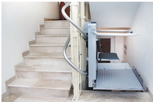
Abb. 5.25 Rollstuhl-Schrägaufzug im Innenbereich. (Quelle: HIRO Lift ©, Bielefeld)
