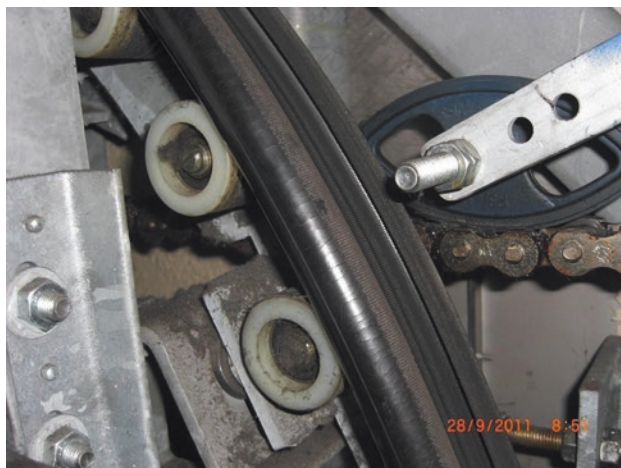
Abb. 19.17 Handlaufführung hinter der Balustradenverkleidung (Quelle: Autor)
