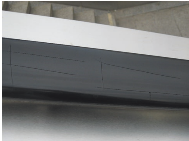
Abb. 23.2 Vandalismus-schaden an einem Handlauf (Quelle: Autor)
