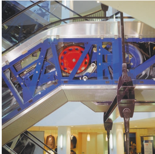
Abb. 19.1 Fahrtreppengerüst (blau) mit Handlaufantriebsrad (rot) (Quelle: Schindler Aufzüge und Fahrtreppen GmbH, Berlin)
