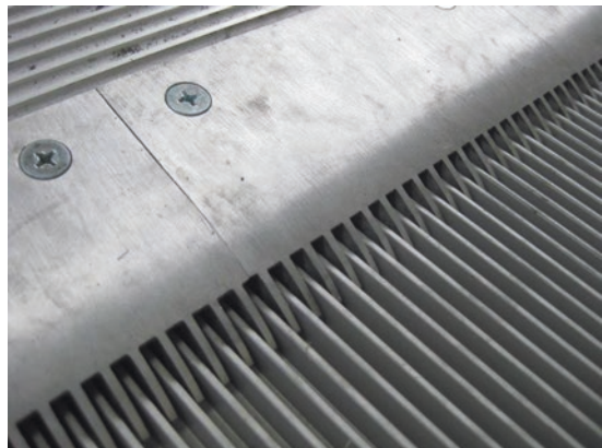
Abb. 19.27 Befestigungsmöglichkeit der Kämme an der Kammlatte (Quelle: GEYSEL Fahrtreppen, Köln)
