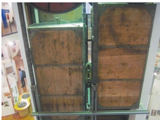
Abb. 5.10 Ansicht der Fahrkörbe von der Rückseite (Quelle: TECH- NOSEUM (Landesmuseum für Technik und Arbeit), Mannheim)
