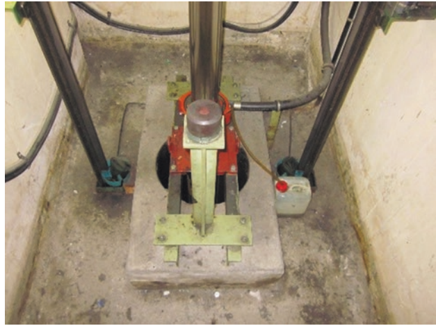
Abb. 4.45 Blick in die Schachtgrube eines direkt hydraulischen Aufzuges mit Zentralstempel in der Erde (Quelle: Autor)
