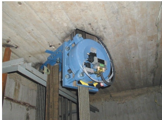
Abb. 4.115 Seilbremse unter der Schachtkopfdecke eingebaut (Quelle: Bode Components GmbH, Düsseldorf)
