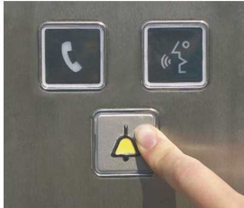
Abb. 6.1 Notruftaster im Fahrkorb (Quelle: GS electronic GmbH, Rheine)
