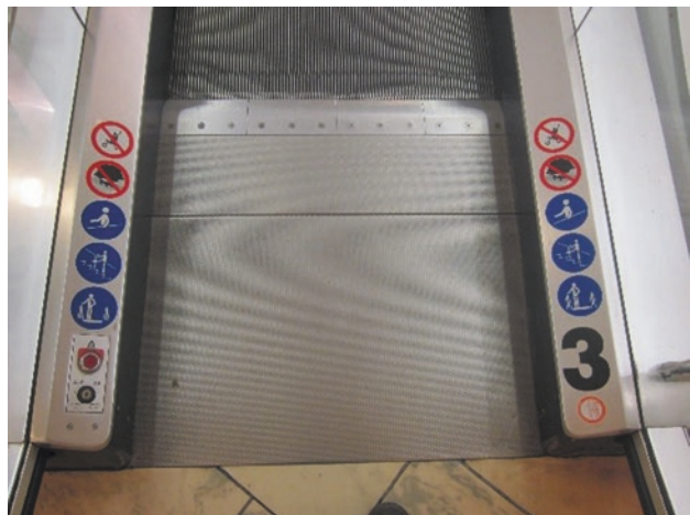
Abb. 19.10 Ansicht untere Landestelle mit Umkehrstation (Quelle: Autor)
