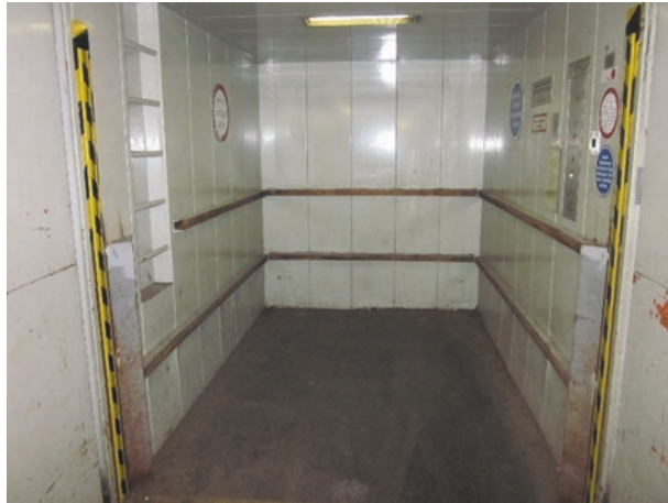
Abb. 5.2 Ansicht eines Fahrkorbs eines Lastenaufzugs mit Sicherheitslichtgitter (Quelle: Autor)
