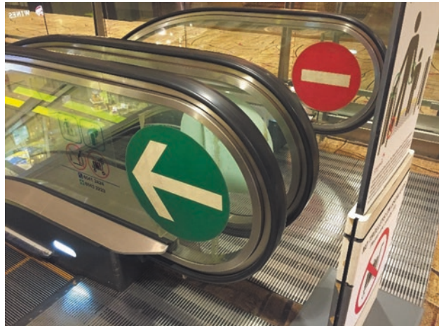
Abb. 19.33 a und b Fahrtrichtungsanzeige in grün, Fahrtrepppe in Laufrichtung benutzbar. Rote Leuchte, Fahrtrepppe nicht benutzbar, da Laufrichtung entgegengesetzt (Quelle: Autor)
