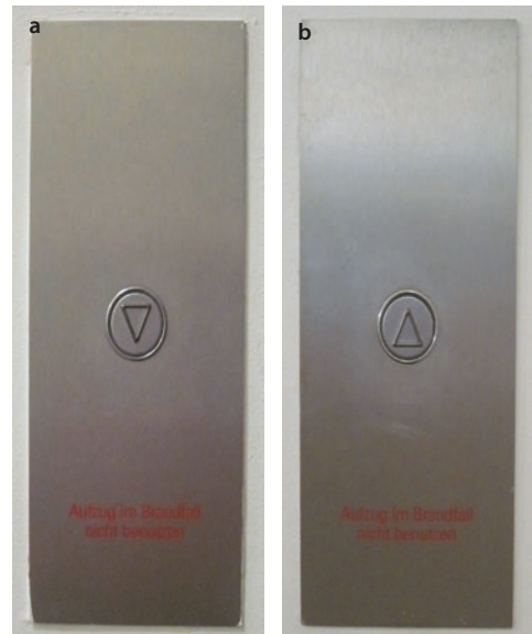
Abb. 4.61 a + b Außenruftableaus in den Endhaltestellen (Quelle: Autor)
