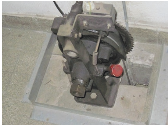
Abb. 4.96 Geschwindigkeitsbegrenzer einer älteren Anlage Baujahr um 1965 (Quelle: Autor)
