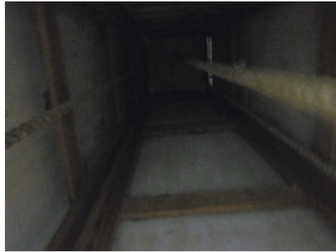
Abb. 5.3 Seil im Schacht zum Bewegen des Fahrkorbs (Quelle: Autor)
