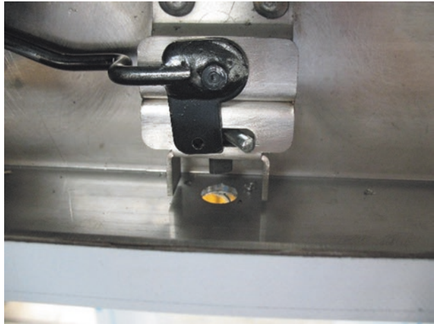
Abb. 4.88 Entriegelungsmechanismus (Quelle: Meiller Aufzugstüren, München)
