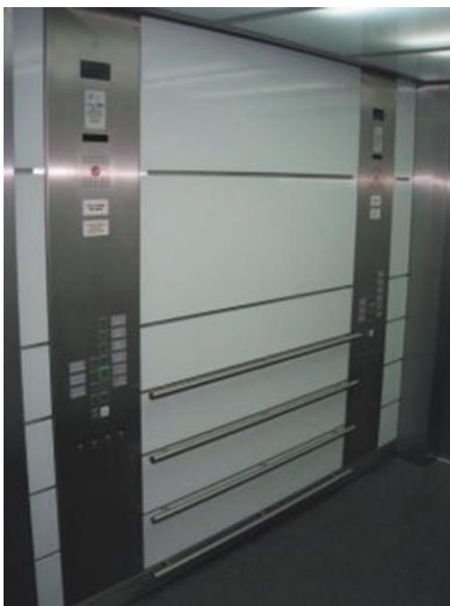
Abb. 4.68 Einsatzfahrkorb aus Glas, farblich hinterlegt (Quelle: Peter Hahn, Liftdesign, Seligenstadt)
