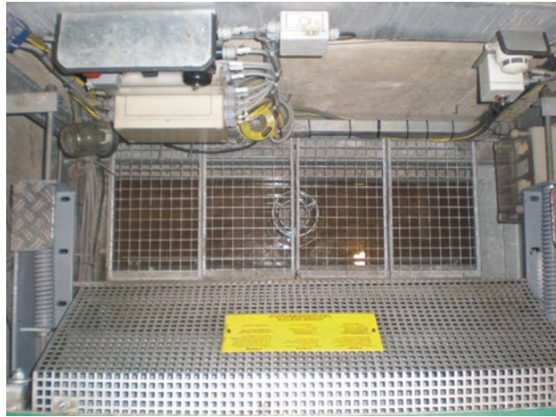
Abb. 19.9 Revisionssteuerung mit Anschlusskabel (Quelle: Escalator Parts Catalogue, Unitec, Oktober 2008)
