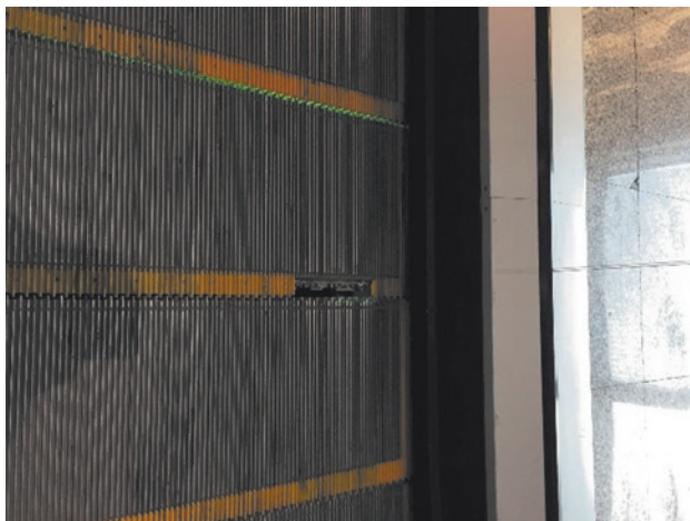
Abb. 23.6 defekter Insert auf einer Fahrtreppenstufe (Quelle: Autor)
