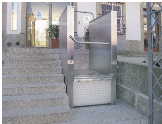
Abb. 5.7 Rollstuhlhebebühne zur Überbrückung von Treppenstufen. In der unteren Haltestelle dient eine Schranke als Abschluss. (Quelle: HIRO Lift ®, Bielefeld)
