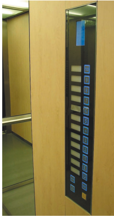
Abb. 4.72 Fahrkorbinnentableau aus Glas mit Sensortaster (Quelle: KW Aufzugstechnik GmbH, Oberursel)
