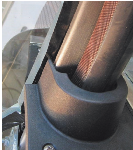
Abb. 19.28 Handlaufeinführung an der Landestelle unterhalb der Balustrade (Quelle: GEYSEL Fahrtreppen, Köln)
