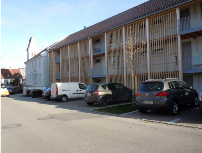
Abb. 10 Windach ,Altbau und Neubau nebeneinander, Wonneberger 2017
