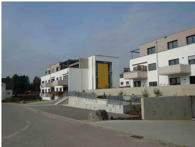
Abb. 5 Außenanlage Burgrieden, Foto Wonneberger 2016
