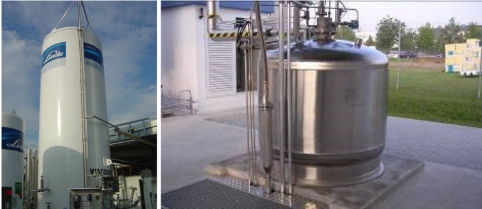
Abb. 5.13 Kryospeicher für Wasserstoff mit Befüllstutzen am HyCentA
