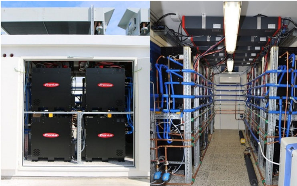
Abb. 4.14 100 kW Elektrolysecontainer mit 12 modularen PEM Elektrolysemodulen
