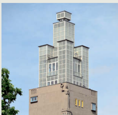
Der Aussichtsturm Rotehornpark blieb erhalten, ein Denkmal des Neuen Bauens der 1920er-Jahre.
