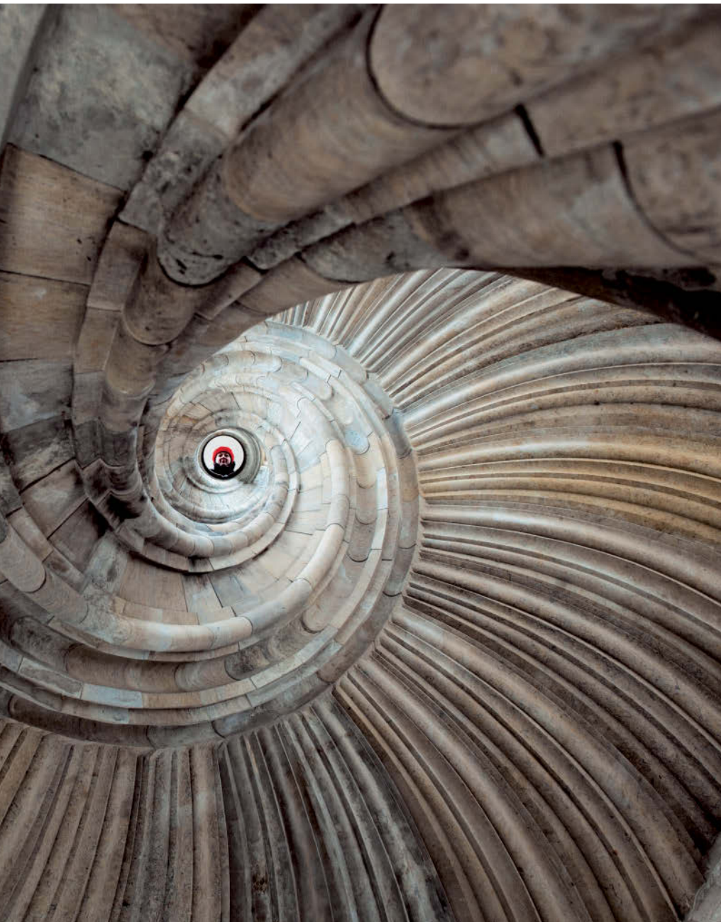
Großer Wendelstein im Schloss Hartenfels: Ohne mittlere Stütze trägt sich die spindelförmige Treppe selbst – seit gut 500 Jahren.
