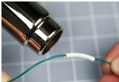
Abbildung 3-49. Erhitze den Schrumpfschlauch.
