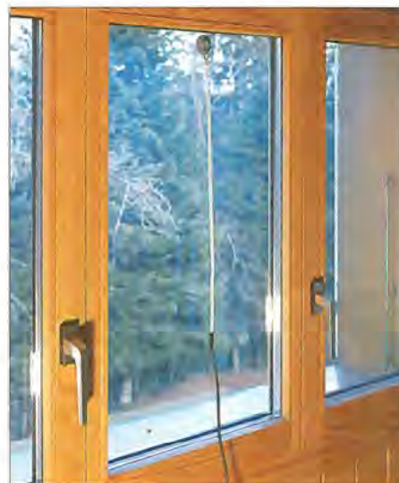
Bild 7: Ein Saugnapf hält die Notfunkantenne an ihrem Platz.
