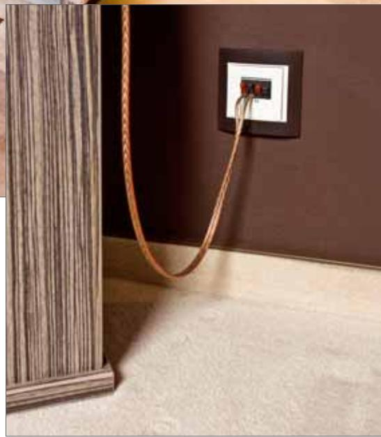
Die hinter den Trockenbauwänden verlegten Lautsprecherkabel enden an speziell dafür vorgesehenen Lautsprecherbuchsen, die einen sauberen Abschluss gewähren
